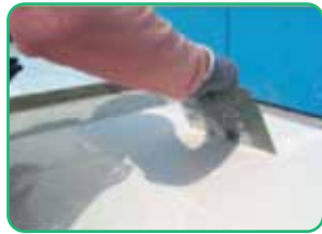
7. Pemasangan Nat Keramik Grout Installation
