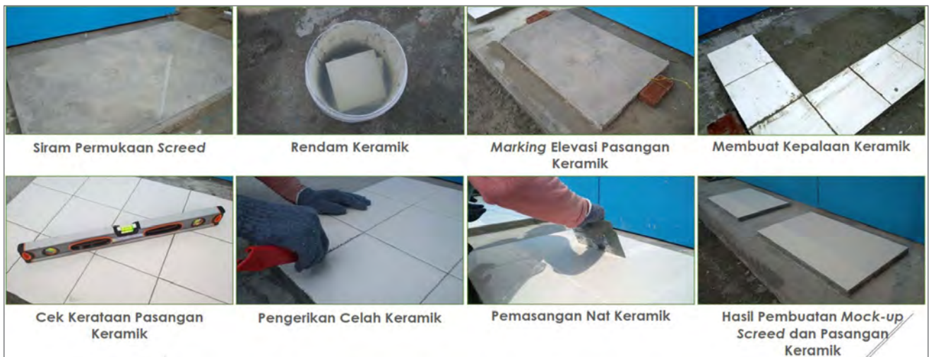
Pembuatan mock-up pasangan keramik
