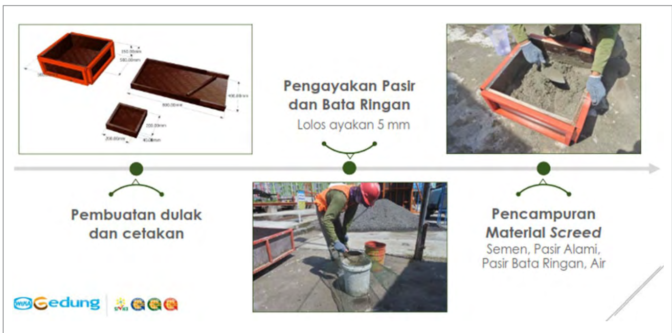
Pembuatan sample screed
