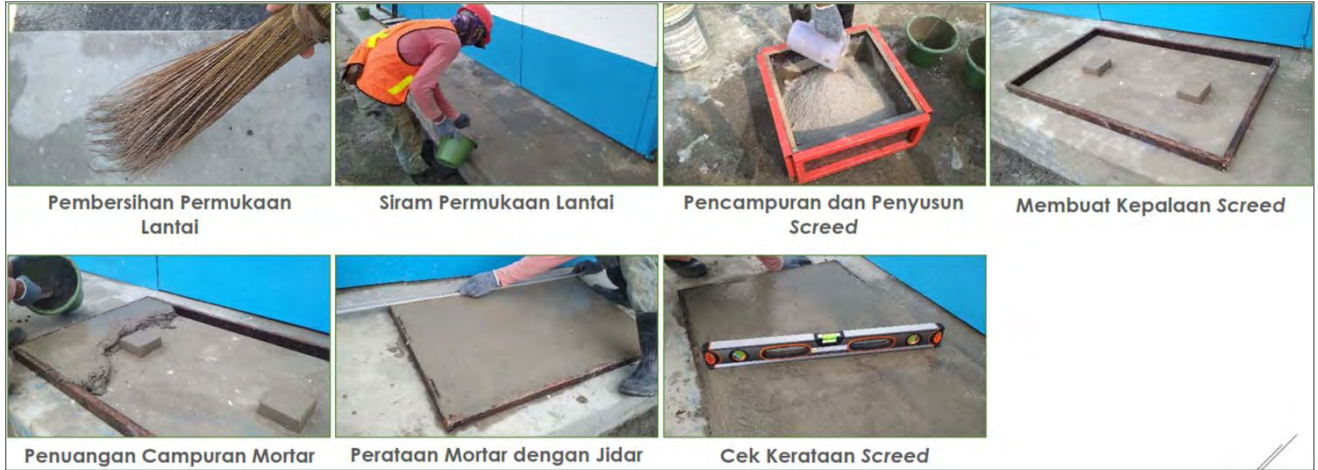
Implementasi pembuatan mock-up screed
